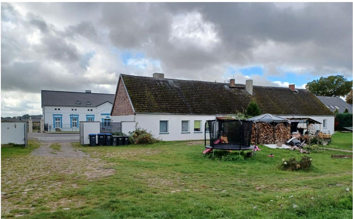
Abbildung 10: Bestandgebäude und Rasenfläche auf Vorhabensfläche (Foto Grünspektrum, 16.10.2025)
