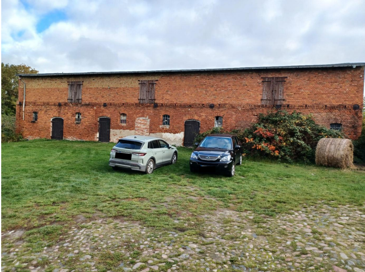
Abbildung 4: Blick auf die abzureißende Scheune (Foto Grünspektrum, 16.10.2025)
