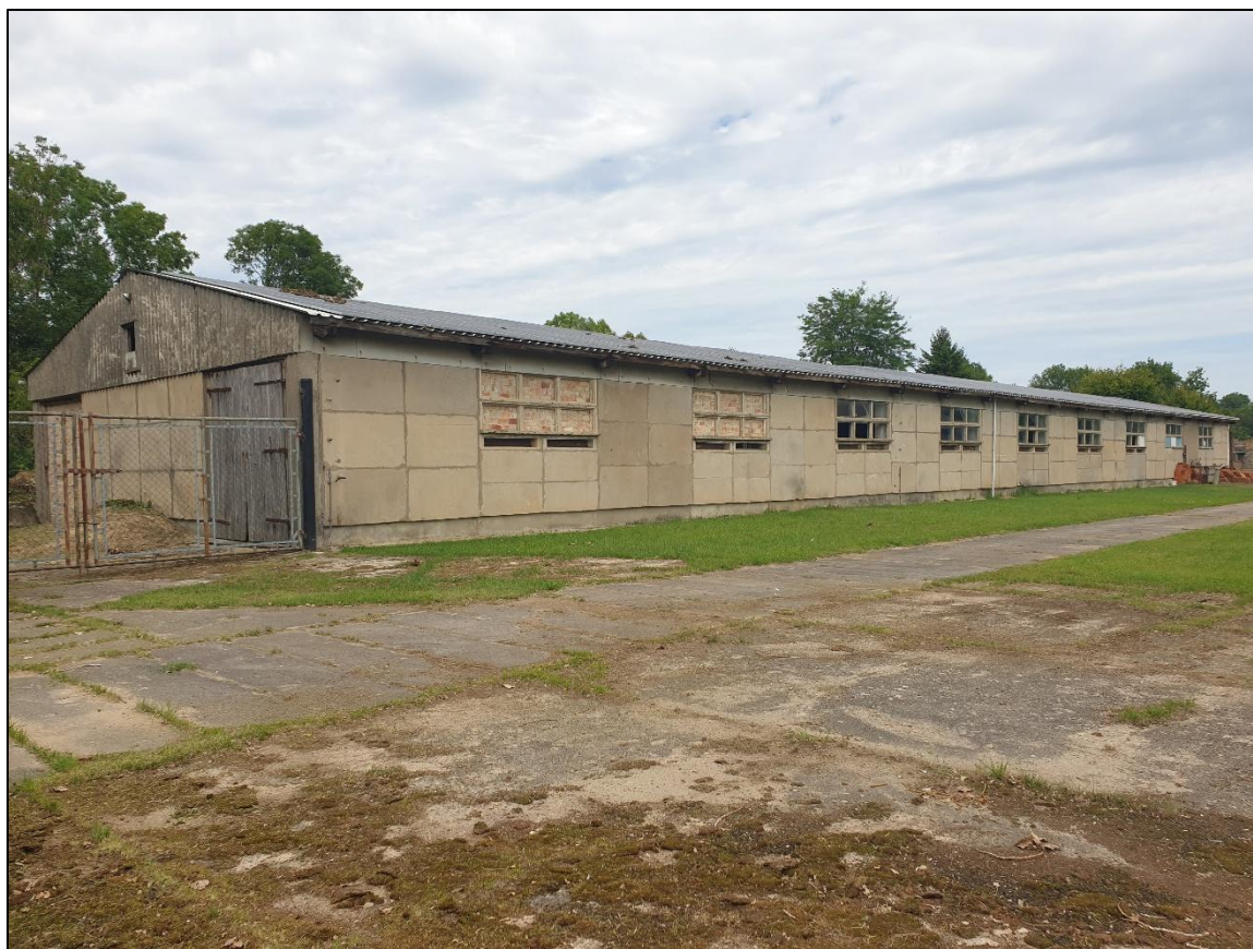
Abbildung 8: Eine der größeren Lagerhallen im nördlichen Teil des Plangebiets.
