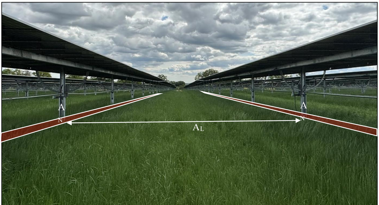
Abbildung 4: Beispiel einer Agri-PV-Anlage mit nachgeführten Horizontaltrackern in der Gemeinde Tützpätz, Vorhabenträger Vattenfall. Vorhabenstandort Tützpätz. Foto: Leddermann – Mai 2025
