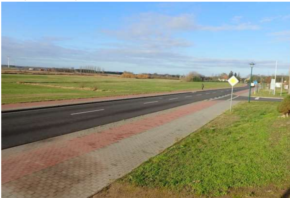
Bild 01 Plangebiet vom Osten
